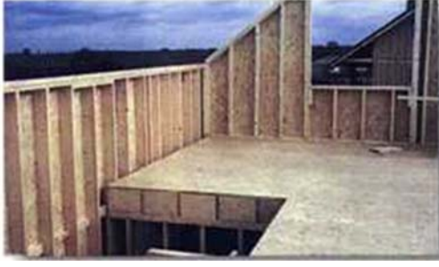
Şekil 3, Ahşap Panel Sistemler
