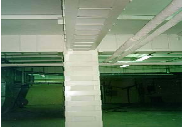
Şekil 6. Kolonların Çelik Manto ile Güçlendirilmesi.
